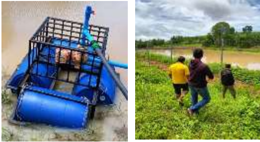
โครงการซ่อมแซมระบบประปาบ้านสุโขงบาดูฯ
