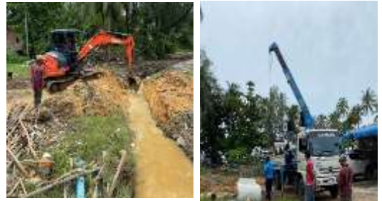
ขุดลอกคูระบายน้ำและวางท่อระบายน้ำ หมู่ที่ ๖
