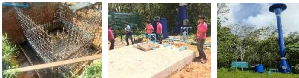
โครงการก่อสร้างถังเก็บน้ำบ้านโคกสะท้อน หมู่ที่ ๑
