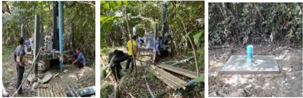
โครงการขุดเจาะบ่อบาดาลบ้านเกาะมุกด์ หมู่ที่ ๒ (บ่อที่ ๑)
